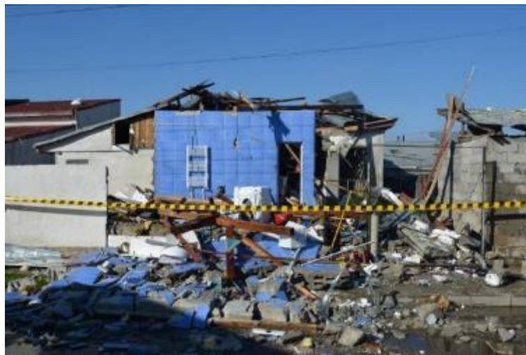
Fig. 2. Partea din față (S-E) a imobilului nr. 51
