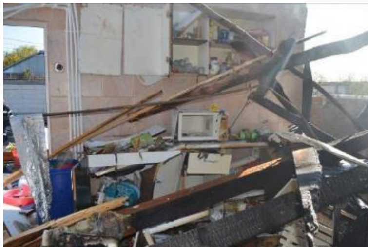
Fig. 4. Peretele dintre bucătărie și baie
